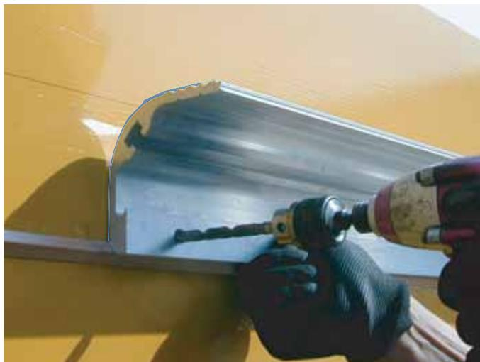
本体を面木の上にのせ、あらかじめ工場で加工された固定用穴からキリで型枠に穴をあけます。
